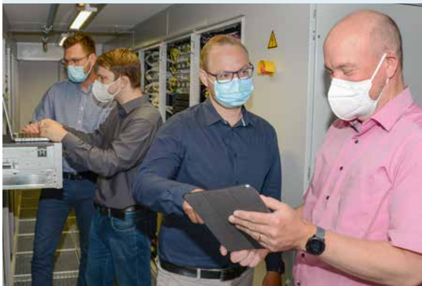
IT-Leitungsteam am HDZ: (v. l.) André Walkenhorst, Lars Jording, Steven Alhorn und Thorsten Krian stimmen sich in einem der Serverräume ab.
