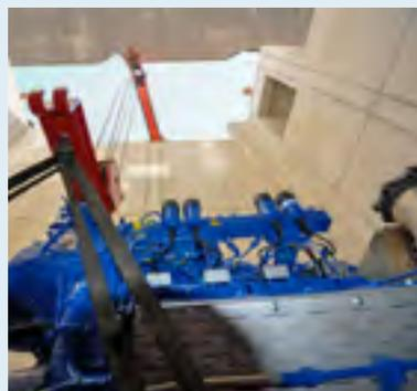
2. Schritt: Das erste Kraftwerk-element wird in das Untergeschoss versenkt.
