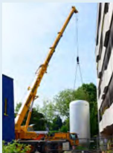
3. Schritt: Ein Jumbo-Kran setzt den Wärmespeicher an Ort und Stelle.
