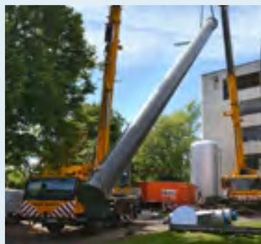
4. Schritt: Es folgt der 21 Meter lange Schornstein. Und das fertige Blockheizkraftwerk kann seinen Betrieb aufnehmen.
